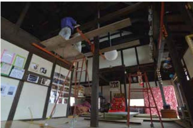
(写真 7-3) 土間と和室の間の柱の撤去
